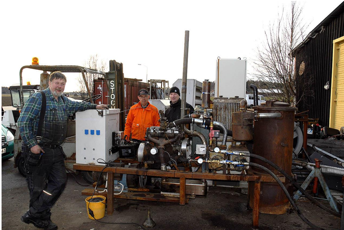
Provkörning av genganläggning i Sätra brunn.
